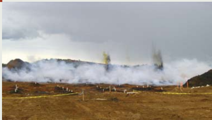
Densification par sautage d'une zone à résidus miniers
